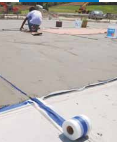
Смесване на Mapelastic с механична бъркалка
