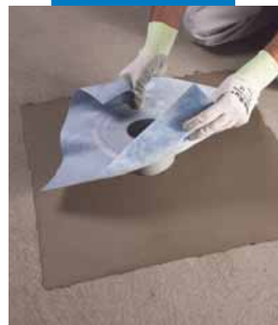
Хидроизолация на плувен басейн с Mapelastic
