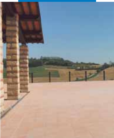
Полагане на плочки с Granirapid върху балкон, който е хидроизолиран с Mapelastic
