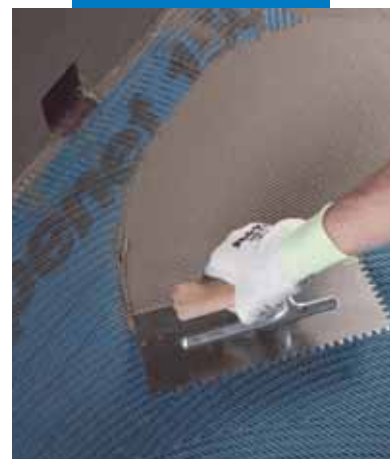
Полагане на керамични плочки върху Mapelastic в плувен басейн
