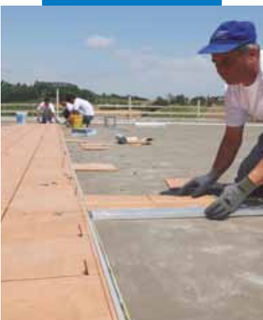
Хидроизолация на балкон с Mapelastic с вмъкната укрепваща мрежа Mapenet 150
